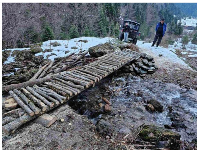
Реконструкција на еден од мостовите на Долна Лешница
